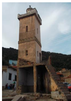
Ancienne mosquée du village (vers 1850)
